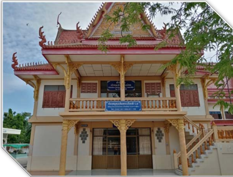
ห้องสมุดเฉลิมพระเกียรติ ร.๙ ก่อสร้างเมื่อวันที่ ๑๑ มกราคม ๒๕๖๓
